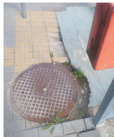
Pav. 6 Nusilupusi šaltilėčio plokščių apsauginė danga, aprūdiję turėklų porankiai, išsiklaipiusi trinkelų danga prieigose
